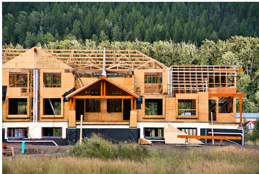
FIGURE 1. Chantier résidentiel en structure de bois. Photographie : Ślusarczyk, licence CC BY 3.0, Wikimedia Commons.
